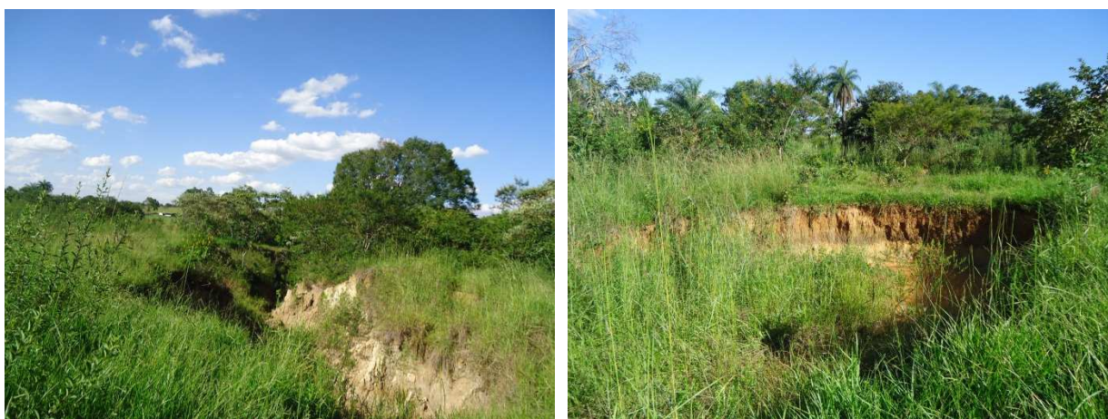
Fotos 13: Erosão a recuperar na propriedade do Ferdinando Fonte: GERHI (2013)
