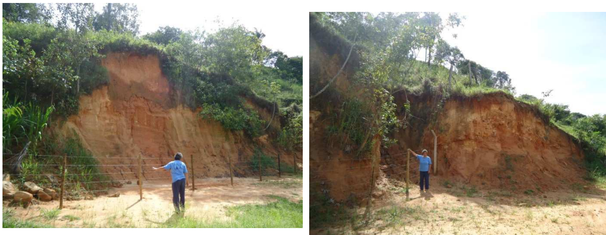
Fotos 9: Erosão a recuperar na propriedade de Maria Sônia Fonte: GERHI (2013)
